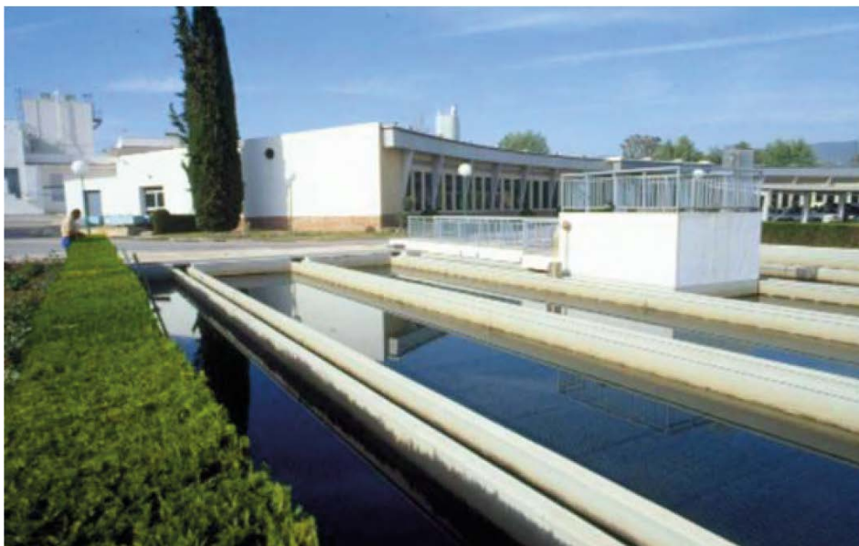
Figura 1.16. Pulsator Lamelar-EMACSA (Córdoba).
