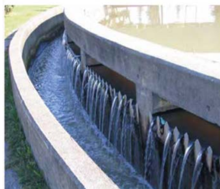
Figura 1.11. Esquema de un Accelator (izquierda); detalle de vertederos de recogida de agua decantada (derecha).
