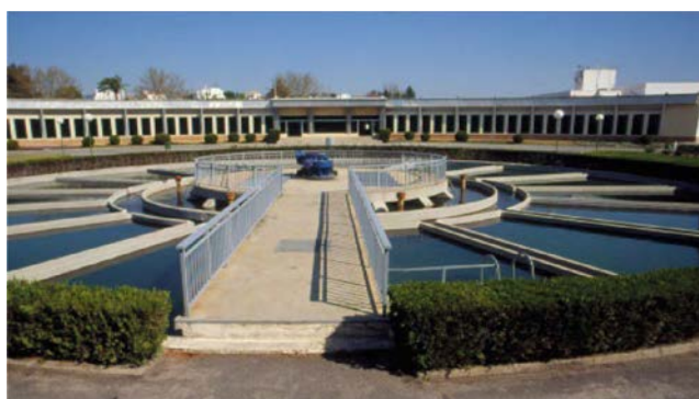
Figura 1.12. Decantador Accelerator ETAP-EMACSA (Córdoba).
